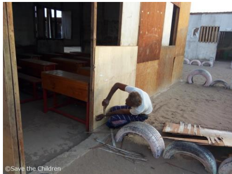
校舎の修繕を行う保護者会メンバー (2023年10月撮影)
