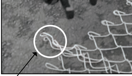
Revise la malla para verificar que no haya puntas o nudillos que no estén a la misma altura de los demás. Si los hay, necesitará hacer ajustes en esa área.
