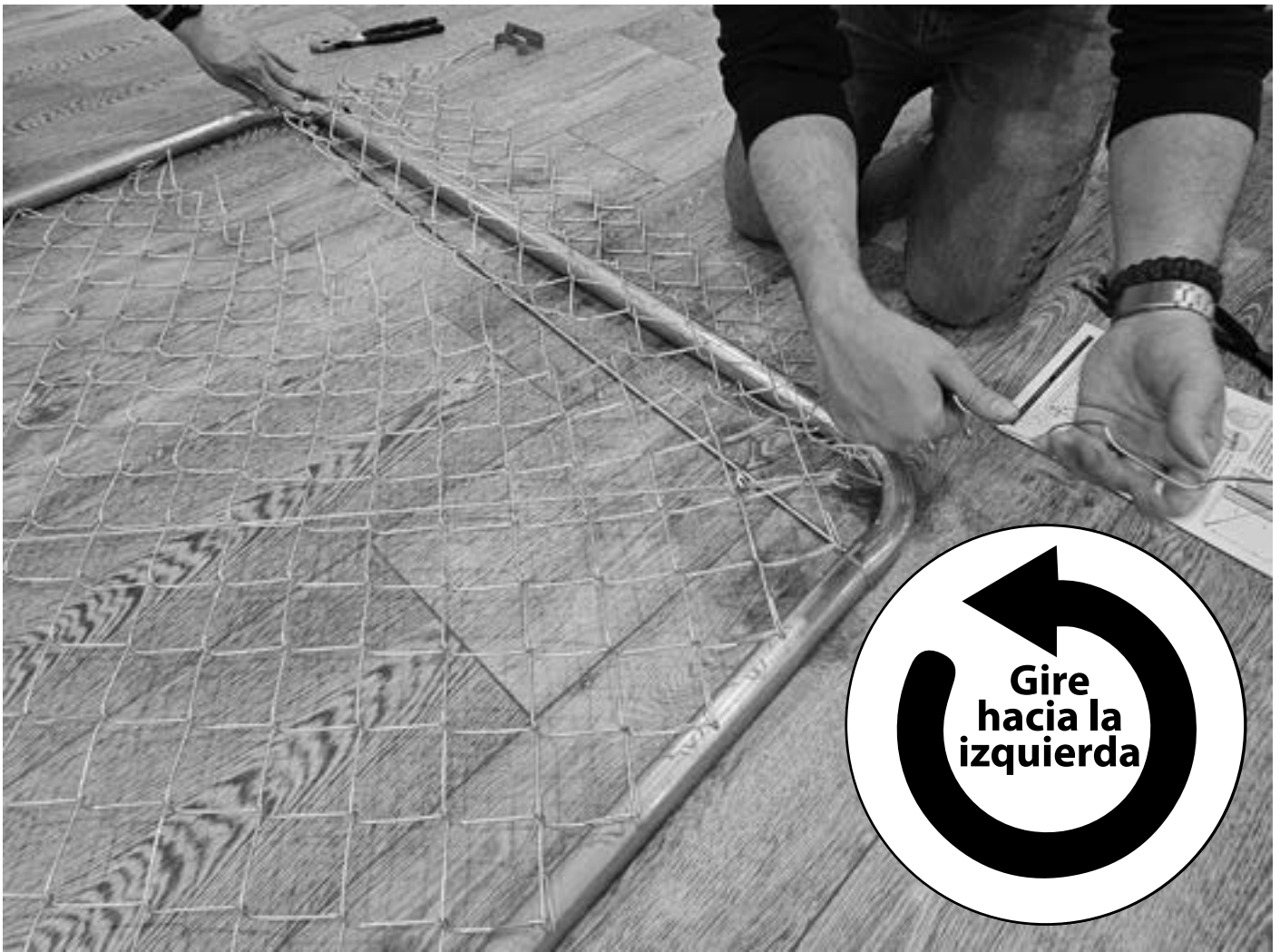
En la parte superior de la estructura: Corte justo antes del nudillo
