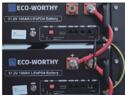
③ Connecter les batteries avec les fils de communication de la batterie.
