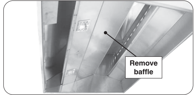
Fig. 12-1 Remove baffle
