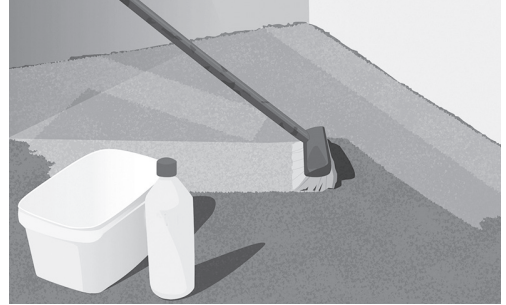
Fig.3. Rengjør gulvet og påfør grunning
