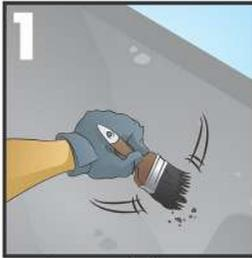
1 Antes de preparar el adhesivo, es necesario acondicionar la superficie, la cual deberá estar limpia, resistente, firme, sin grietas, seca y dimensionalmente estable (concreto curado a 28 días).
