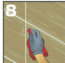
Limpe los residuos de adhesivo una vez terminada la instalación con una esponja o trapo húmedo.
