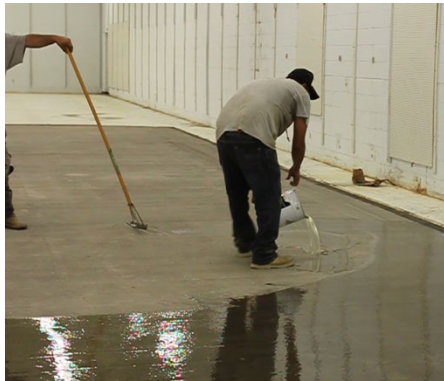
Pour mixed material out in ribbon
