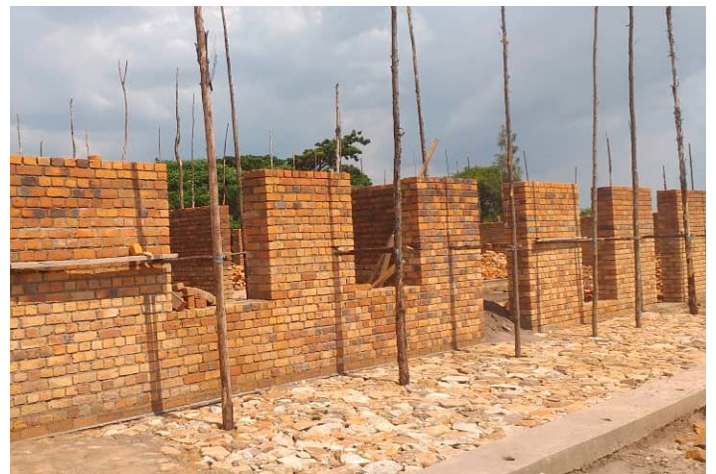
Bau des Speisesaals
