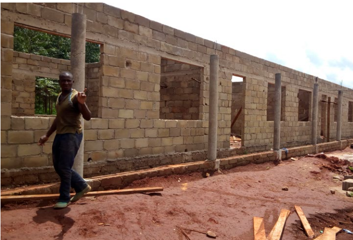
Rohbau der Schule
