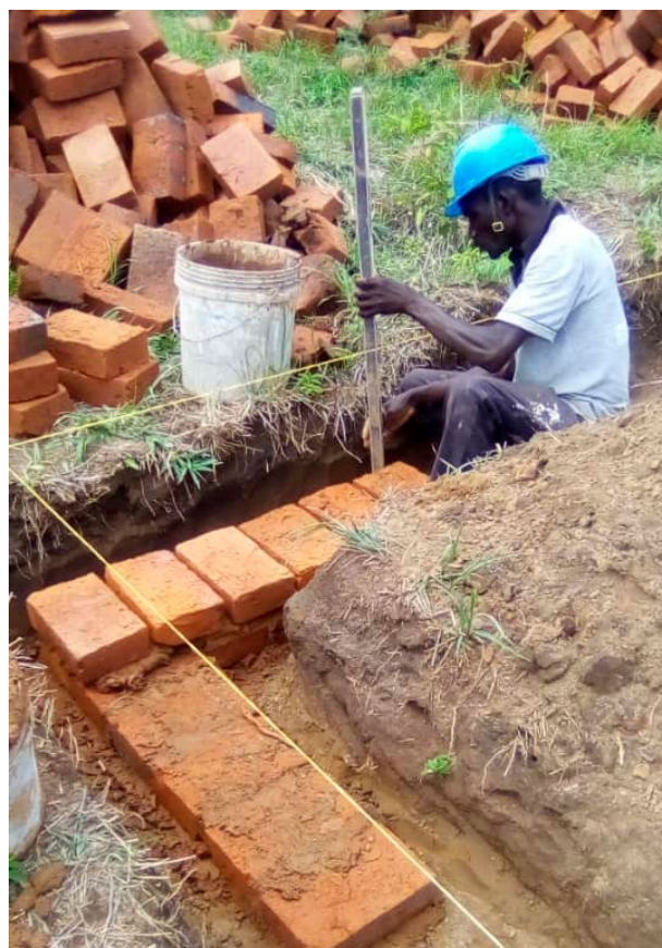
Der Bau des Ladens geht voran
