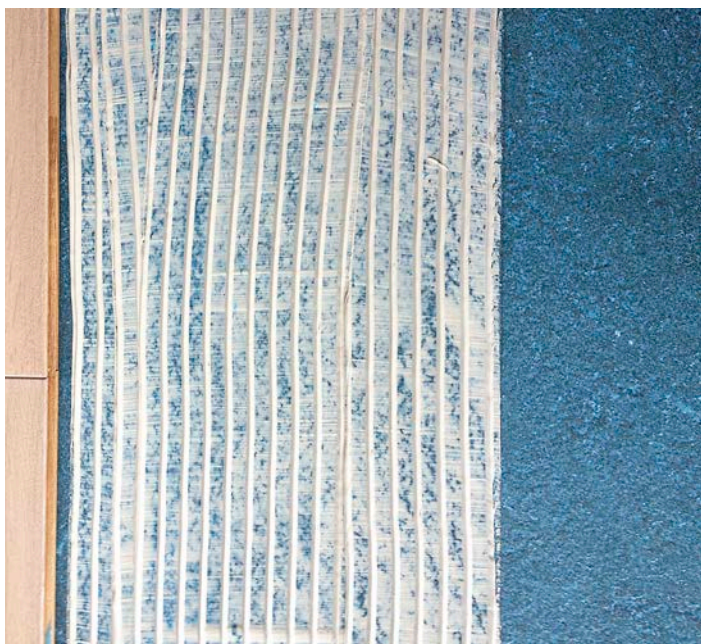
Bildene viser heltre eikegulv som hellimes ned på betong. Betongen har blitt behandlet med fuktsperre først.
