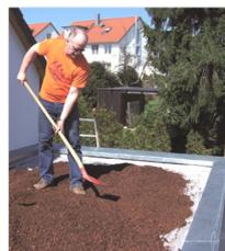
Die Systemerde „Steinrosenflur“ wird gleichmäßig in einer Höhe von 6–8 cm auf dem Systemfiltervlies verteilt. Aus gestalterischen Aspekten und um den Artenreichtum zu erhöhen sind natürlich auch Anhögelungen möglich.
