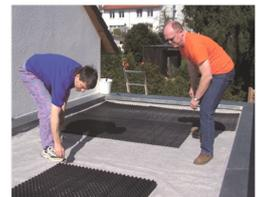
darauf, dass die Diffusionsöffnungen in den „Höckern“ nach oben zeigen (siehe Bild ganz oben). Auch beim Dränelement ist ein entsprechendes Loch über dem Dachablauf auszuschneiden.
