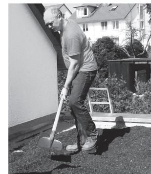
Sie wird gleichmäßig in einer Höhe von mind. 6 bis 8 cm auf dem Filtervlies verteilt. Aus gestalterischen Aspekten sind natürlich auch Anhängelungen möglich.
