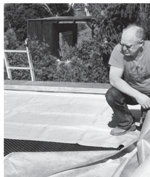
Verlegen Sie das Vlies mit 5 bis 10 cm Überlappung so auf den Drainage-Elementen, dass diese komplett abgedeckt sind. Auch hier ist wieder ein Loch über dem Ablauf auszuschneiden.
