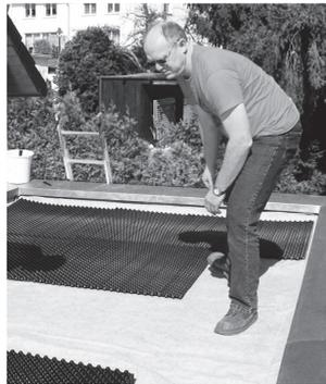
Je nach Dachgröße können die Elemente entweder auf Stoß oder mit etwas Überlappung auf der Speicherschutzmatte ausgelegt werden. Achten Sie unbedingt darauf, dass die Diffusionsöffnungen in den „Höckern“ nach oben
