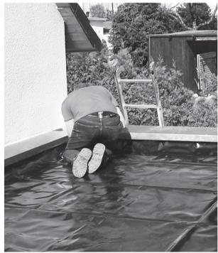
**Achtung:** Die Wurzelschutzfolie ersetzt nicht die Dachabdichtung
