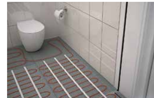
2 Aplicar pegamento flexible sobre la malla Ecofloor.
