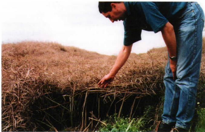
Bild 7: Lager setzt Kostenkette in Gang (Fotos: Verfasser)
