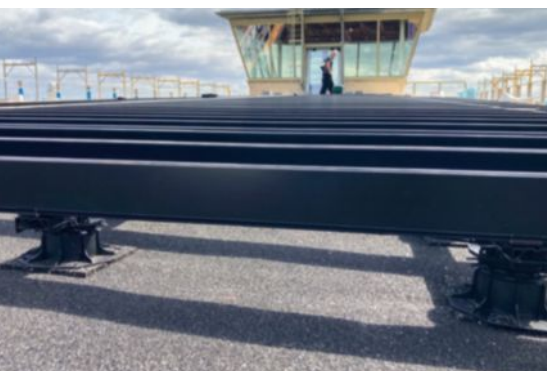
Der Höhenausgleich der Aluminiumkonstruktion wurde mit Stelzlagern vorgenommen.
