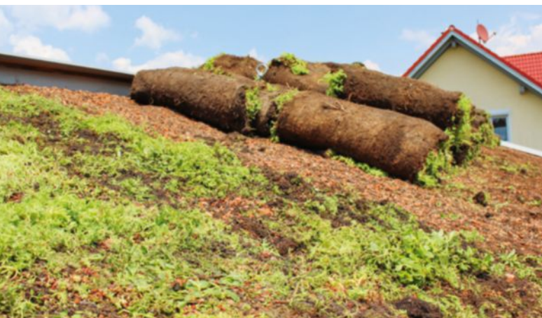
Das Ausrollen der Vegetationsmatten, die nach dem Abladen zuerst am First entlang verteilt wurden, geht sehr zügig. Die obere Sicherung mittels Kabelbinder hat sich bewährt.
