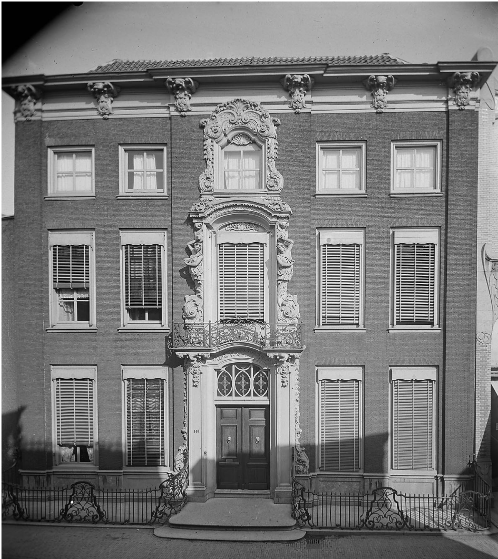
Voorstraat 178. De stoep en het fraaie hekwerk is nog aanwezig
