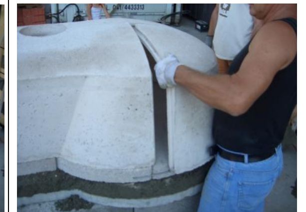
Appoggio dei voltini avendo cura che siano perfettamente combacianti fra loro e inserimento delle graffe di fissaggio APPLICARE IL QUANTITATIVO DI GRAFFE NON SUPERIORE A QUANTE NECESSARIE vedi foto illustrative.
