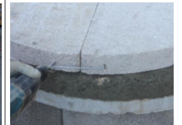
Appoggio dei voltini avendo cura che siano perfettamente combacianti fra loro e inserimento delle graffe di fissaggio APPLICARE IL QUANTITATIVO DI GRAFFE NON SUPERIORE A QUANTE NECESSARIE vedi foto illustrative.
