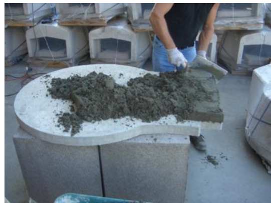
Predisposizione dello strato di coibentazione inferiore di 7 cm di argilla e cemento
