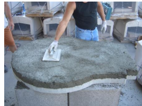
Appoggio delle basi del forno con controllo tramite livella bolla
