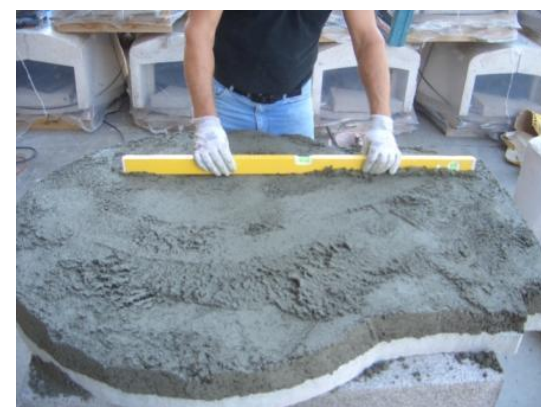
Predisposizione dello strato di coibentazione inferiore di 7 cm di argilla e cemento
