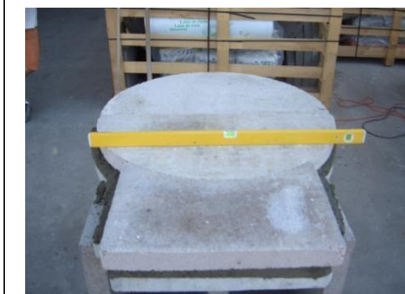
Appoggio dei voltini avendo cura che siano perfettamente combacianti fra loro e inserimento delle graffe di fissaggio APPLICARE IL QUANTITATIVO DI GRAFFE NON SUPERIORE A QUANTE NECESSARIE vedi foto illustrative.
