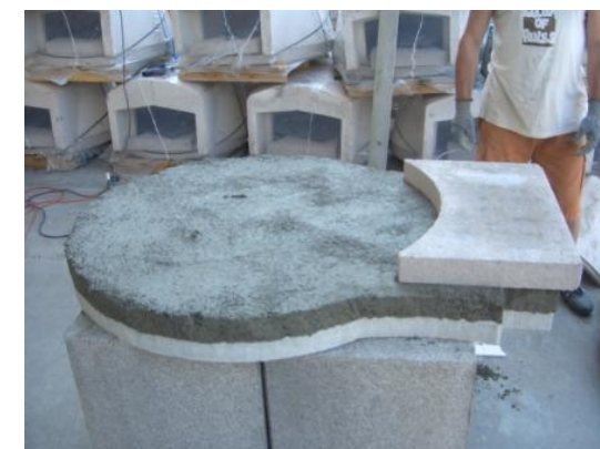
Appoggio delle basi del forno con controllo tramite livella bolla
