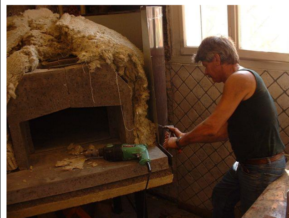
Posizionamento della lana di roccia spessore 10 cm. densità 100 su rete metallica.
