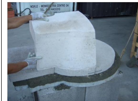
Appoggio dei voltini avendo cura che siano perfettamente combacianti fra loro e inserimento delle graffe di fissaggio APPLICARE IL QUANTITATIVO DI GRAFFE NON SUPERIORE A QUANTE NECESSARIE vedi foto illustrative.
