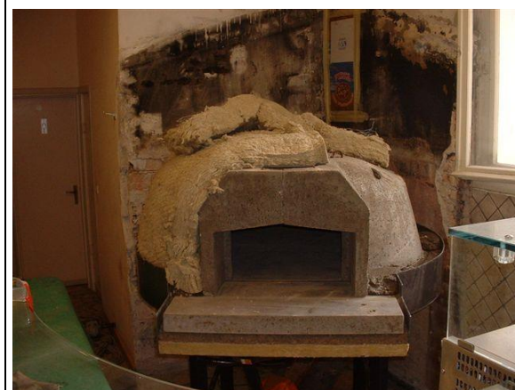
Posizionamento della lana di roccia spessore 10 cm. densità 100 su rete metallica.
