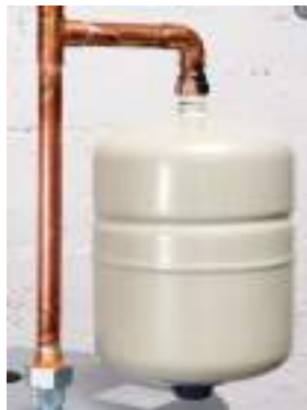
Fig. 5 - Un depósito de expansión térmica ayuda a proteger el sistema de fontanería de la casa de los picos de presión.
