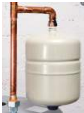
Fig. 5 - Un réservoir d'expansion thermique aide à protéger le système de plomberie de la maison contre les pics de pression.
