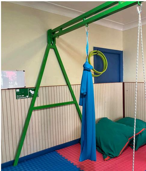
**Estructura sujeta a piso y muro**
