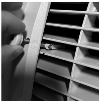
5. Serrez légèrement l'écrou pour le fixer en place, mais laissez de la place pour installer le cadre latéral.
