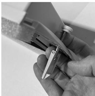
2. Installez la pince de fixation en option et laissez l'écrou desserré pour permettre la fixation du cadre central à l'unité TCTA.
