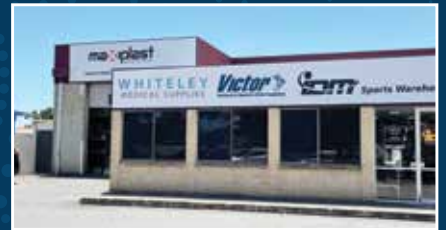
SA Store & Warehouse
