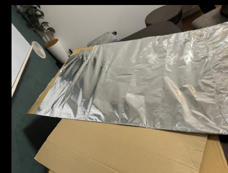
⑧一巻目が完了。仮止め。
