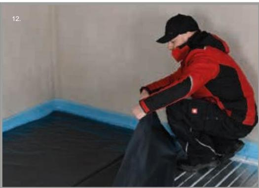
Die PE-Folie dient als Trennschicht zum Folgewerk Estrich, z.B. als Lastverteilschicht Trockenestrichplatten von Knauf (Herstellerangaben sind zwingend beachten).
