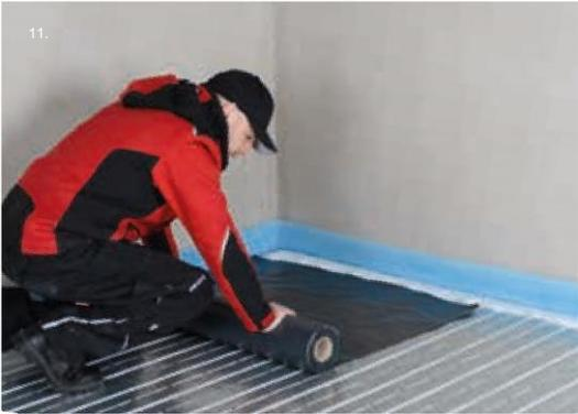
Die komplett verlegte Fläche ist überlappend mit PE-Folie abzudecken.
