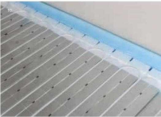
Mit Heizrohr und Wärmeleitblechen verlegte Profil-Plattenfläche.
