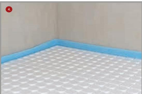
4. Vollflächig verlegte Fläche mit Profilplatten.
