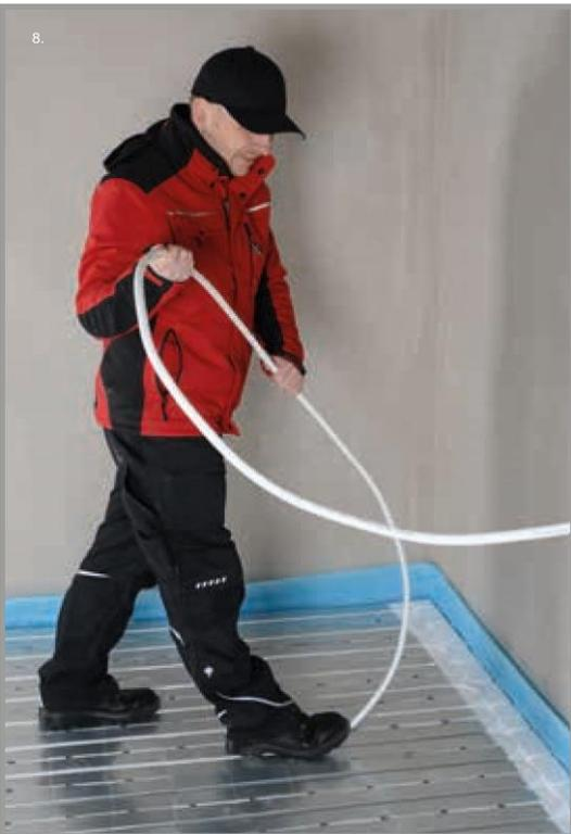
Die Wärmeleitbleche ermöglichen eine schnelle Ein-Mann-Rohrverlegung. Das Heizrohr wird in die spezielle  $\Omega$ -Rohrführung der Wärmeleitbleche eingedrückt.
