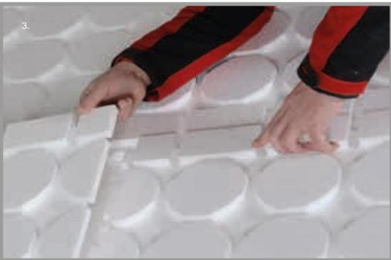
3. Folgeplatten mit Stufen-Hackenfalz anlegen und verbinden.
