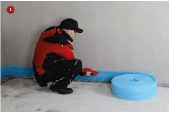
1. Der zu belegende Untergrund ist frei von Putzresten und besenrein vorzubereiten, Deckendurchbrüche müssen belastungssicher geschlossen werden. Der Randdämmstreifen ist an allen Wänden und aufsteigenden Bauteilen (Treppen oder Pfeiler) zu verlegen. Bei mehreren Dämmschichten muss der Randdämmstreifen vor der Verlegung der Profilplatte angebracht werden. Es ist darauf zu achten, dass die Abreisschlitzung des Randdämmstreifens oben ist und der Folienüberstand auf die Profilplatte verlegt wird.
