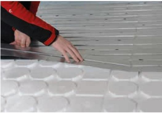
Die Sollbruchstellen der Wärmeleitbleche ermöglichen eine optimale Längenanpassung.
