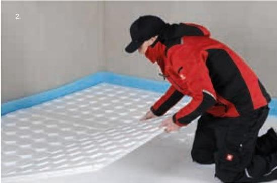
2. Mit der Verlegung der Profilplatten wird in einer Raumecke fugendicht zum Randdämmstriefen begonnen.
