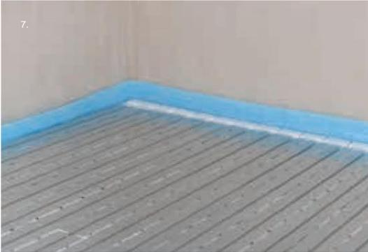
Mit Wärmeleitblechen verlegte Profilplatten-Fläche zur weiteren Verlegung von Heizrohr Ø 14 mm.
