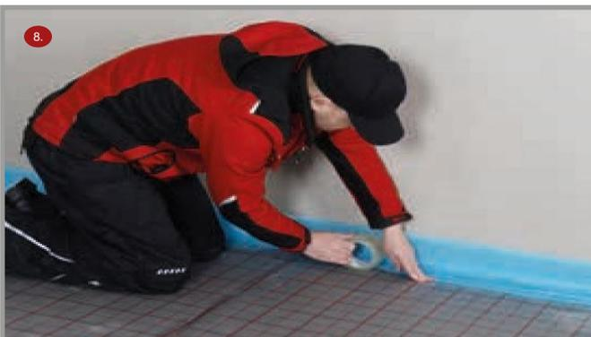
Ebenso muss der Folienflansch des Randdämmstreifens bei Einsatz von Fließestrich auf der Tackerdämmung abgeklebt werden.
