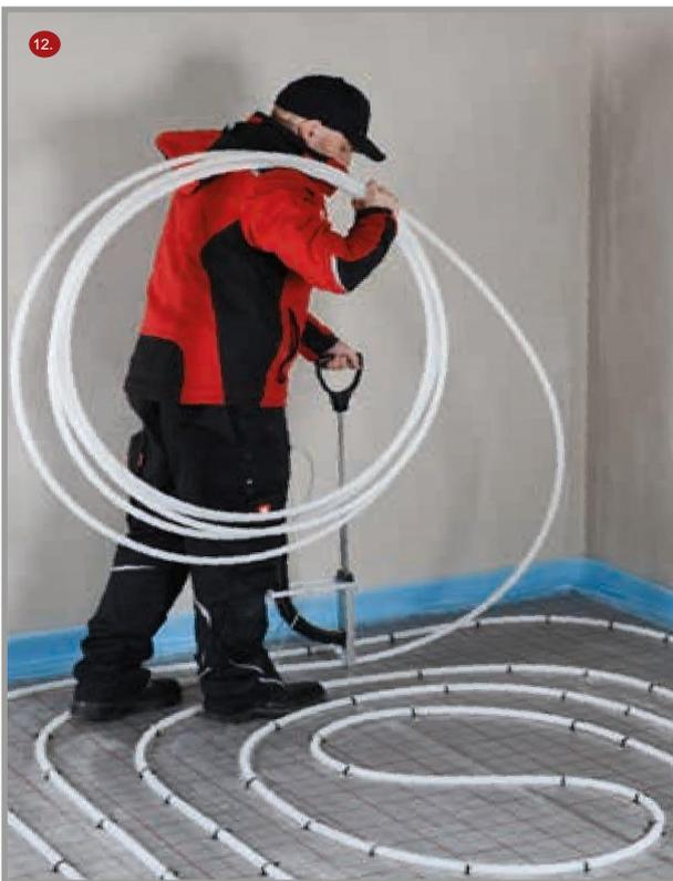
Die gängigste Art der Verlegung ist die Schneckenform. Dabei wird das Heizrohr (Vorlauf) vom Rand des Raumes mit dem doppelten Abstand des gewünschten Verlegeabstands von außen nach innen verlegt. Sobald die Mitte des Raumes erreicht ist wird eine Umlenkung vorgenommen und zwischen den bereits befestigten Heizrohren zurück zum Verteiler (Rücklauf) verlegt. Dadurch entsteht der gewünschte Verlegeabstand.
