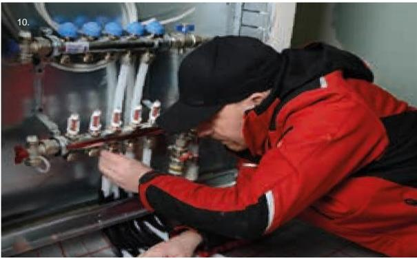
Mit der Verlegung der Heizkreise beginnen Sie am Heizkreisverteiler. Das Heizrohr wird 1. am Vorlauf und 2. am Rücklauf mit Klemmverschraubungen angeschlossen.
