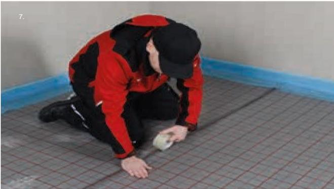
Bei Fließestrich muß die Folienüberlappung der Tackerdämmung mit Klebeband abgeklebt werden. Schnittreste ohne Folienüberstand müssen an den Stoßfugen verklebt werden.
