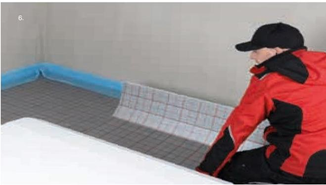
Die Tackerdämmung ist bündig mit dem Randdämmstreifen abzuschließen. Die letzte Platte wird entsprechend des Raumes angepasst und verlegt. Mit der Restplatte beginnen Sie die Verlegung der nächsten Dämmbahn. Damit erhalten Sie einen Versatz, der die Stabilität der Dämmlage erhöht.
