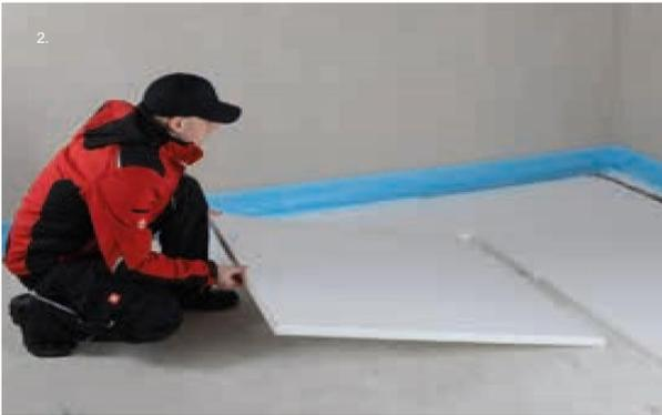
2. Die Dämmungen müssen jeweils dicht gestoßen verlegt werden, bei Verlegung mehrerer Lagen von Dämmungen ist auf einen Fugenversatz zu achten.
