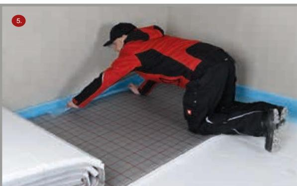
5. Mit der Verlegung der Tackerdämmung (Rollbahn oder Faltpatte) wird in einer Raumecke begonnen, sie ist wandbündig und vollflächig zu verlegen. Die einseitige Folienüberlappung ist längsseitig jeweils auf bereits verlegte Tackerdämmung aufzulegen und bei Einsatz von Fließestrichen abzukleben.
