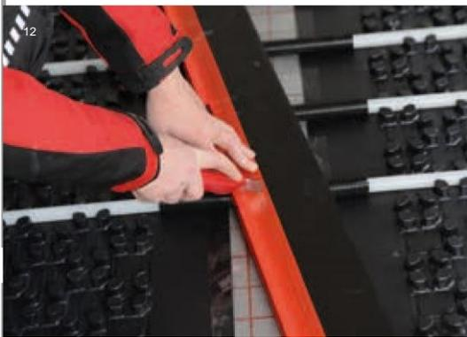
Das Dehnfugenprofil wird entsprechend der Rohrabstände ausgeschnitten.
