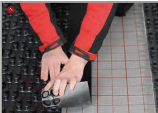
Türdurchgänge, Verteiler- und Dehnfugenbereiche können mit EPS (Rollbahn / Faltplatte) hergestellt werden.
