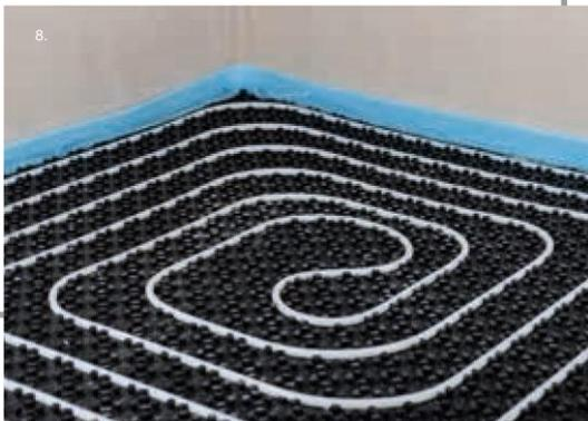
Fertig verlegte Noppenfläche mit schneckenförmig angeordneten Heizrohren.
