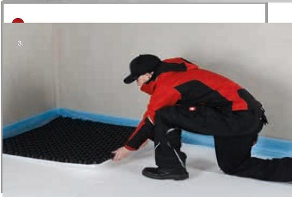
Schnelle Verlegung durch großformatige Noppenplatten, die eine Ein-Mann-Rohrverlegung ermöglichen. Mit der Verlegung wird in einer Raumecke begonnen, sie ist wandbündig mit dem Folienüberstand nach innen.
