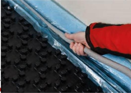
Fixierung des Folienflansches der Randdämmstreifen mit PE-Dichtprofil in der äußeren Noppenreihe.
