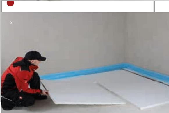
Die Zusatzdämmung muss jeweils dicht gestoßen verlegt werden, bei Verlegung mehrerer Lagen von Dämmungen ist auf einen Fugenversatz zu achten.
