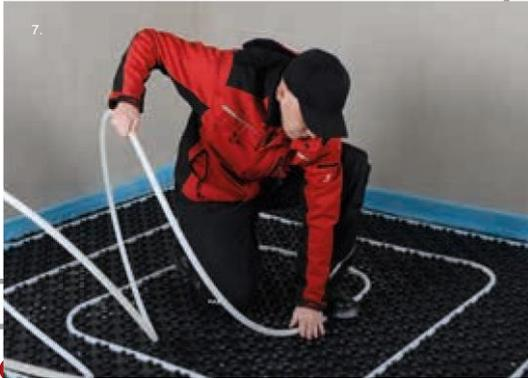
Das Heizrohr ist einfach zu verlegen indem es wird zwischen die Noppen gedrückt wird. Auf eine Entdrallung des Rohres bei der Umlenkung ist zu achten.
