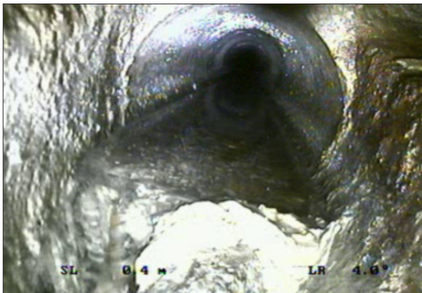
Figur 4-16 Påbyggnad av bland annat äggskal kring sanitärt avfall i ledningsnätet. Ledningen på bilden är av betong med en dimension av 225 mm.
