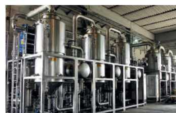
SISTEMAS DE REFRIGERACIÓN
