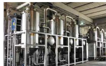
SISTEMAS DE REFRIGERACIÓN
