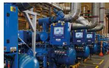
SISTEMAS DE BOMBEO
