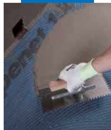
Aanbrengen van Mapelastic op Mapenet 150
