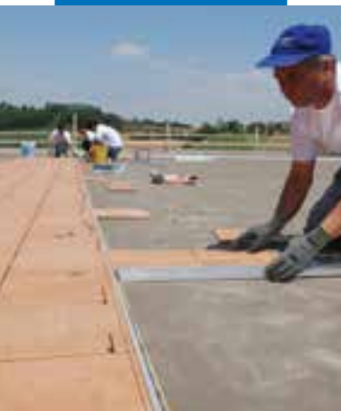
Aanbrengen van keramische tegels met Kerabond + Isolastic
