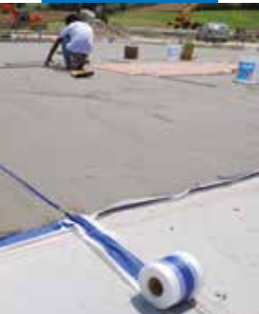
Waterdicht maken van dekvloeren met Mapelastic en Mapeband
