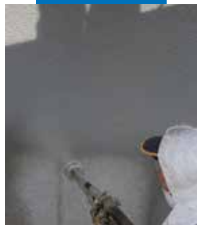
Mapelastic met een spuit aangebracht op een viaduct
