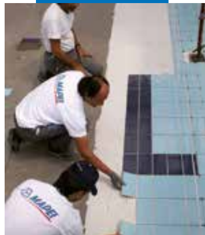
Het leggen van keramische tegels op Mapelastic
