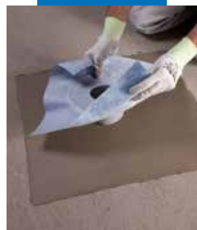
Aanbrengen van een verticale afvoer op Mapelastic
