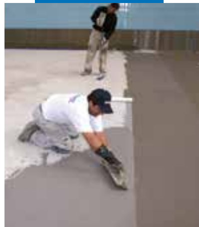
Waterdicht maken van een zwembad met Mapelastic
