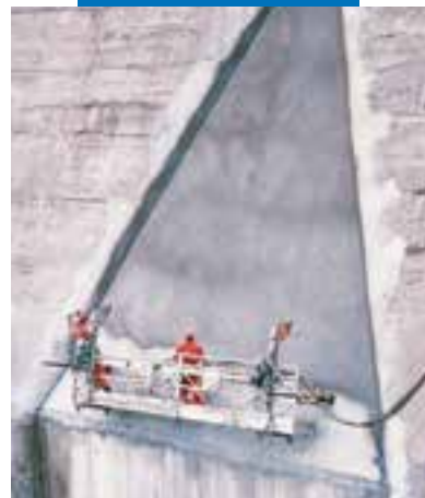
Mapelastic met een spuit aangebracht op een dam
