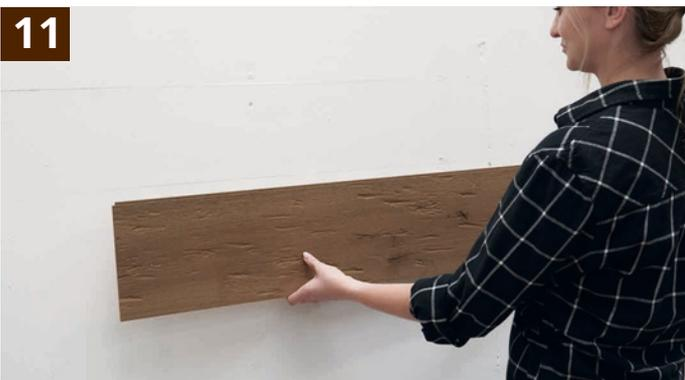
Nach dem Auftragen Montagekleber und dem Anbringen der Pads. Die Diele ausrichten und andrücken, bis die Klebepads greifen.
