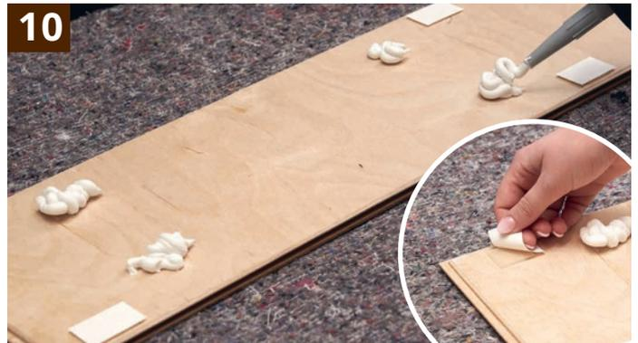
Pärchen aus Klebepad+Kleber entlang der Federkante in einer Reihe mit einem Abstand von 30 – 40 cm anbringen (bei 1,20 m Länge sind das 4 – 5 Pärchen). Bei den untersten Dielen auch eine 2. Reihe entlang der Nut wie auf dem Bild gezeigt. Vor der Montage Schutzpapier entfernen, Klebefläche nicht berühren! (klebt nur 1x)
