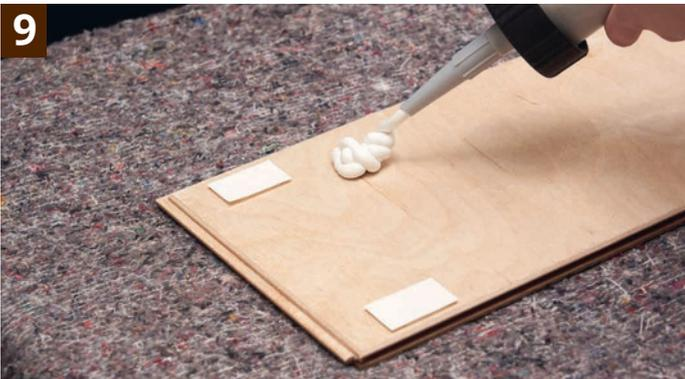
Schutzpapier des Klebepads auf einer Seite entfernen, das Pad auf die Dielenrückseite kleben und sorgfältig festdrücken. Direkt daneben kommt etwas Montagekleber.
