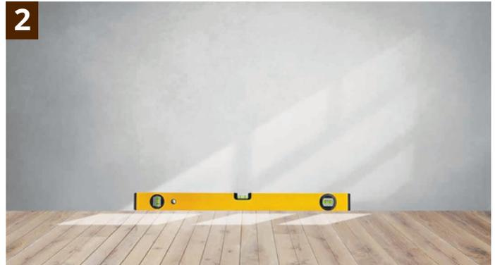
**2** Vorbereitung der Montage. Überprüfen Sie mittels einer Wasserwaage, die Gegebenheiten des Bodens. Bei der Montage der timberwalls echtholz Wandverkleidung muss, ein Sicherheitsabstand von 10mm, rundum eingehalten werden.
