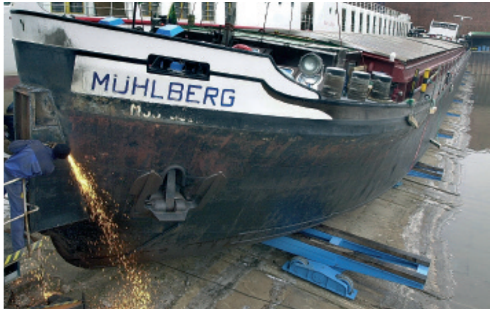
A rampa inclinada que permite colocar o barco na água, é revestida com uma tinta especial para reduzir o atrito e facilitar o movimento.
