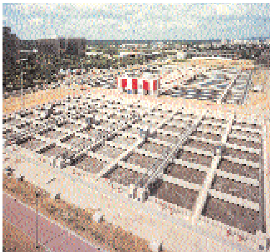
Estação de tratamento de águas.
