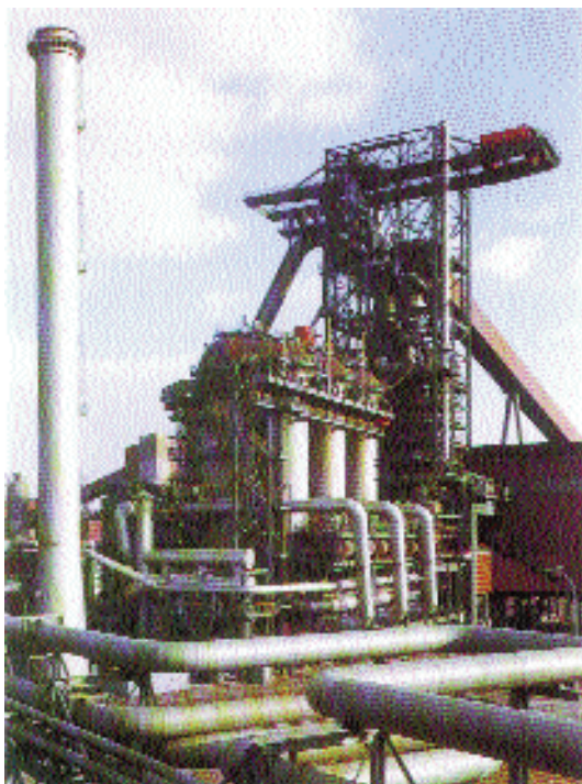
Alto forno que produz 6000 toneladas de ferro em barra, por dia.
