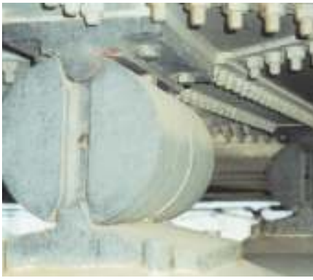
Estes rolamentos permitem que as pontes possam se expandir no verão, sem riscos de colapso.
