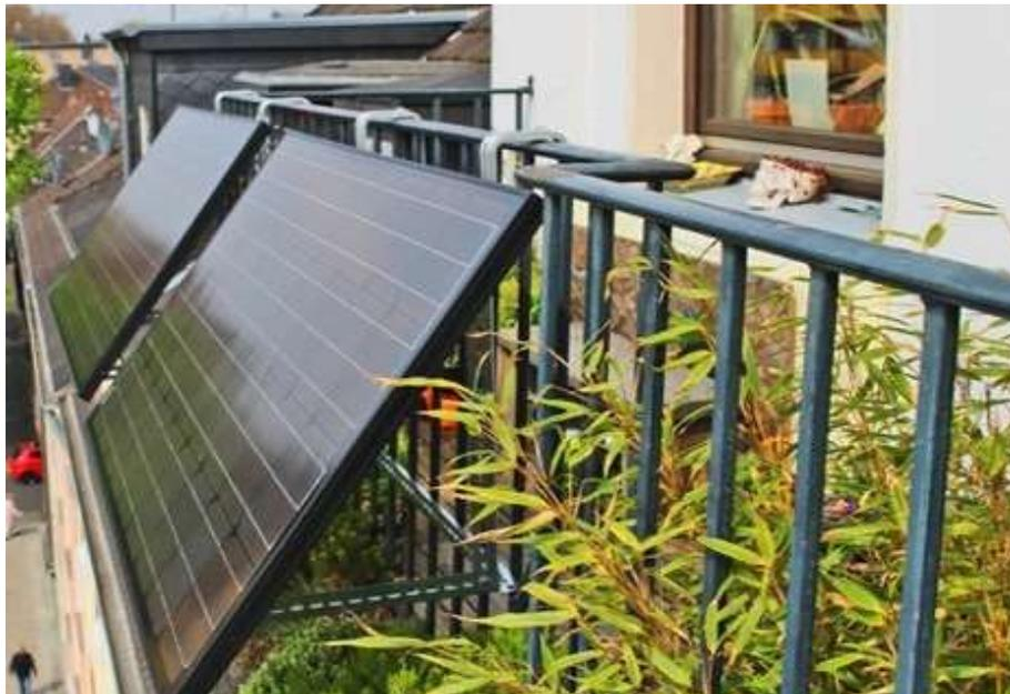
Empfehlenswert ist hier ein Balkonkraftwerk bestehend aus zwei Modulen à 310 Watt (Module mit größerer Leistung sind zu groß für Ihren Balkon) und einem 600 Watt Wechselrichter. Geeignet ist zum Beispiel das folgende Komplett-Set: [Basic Line X-EPP 620 W Komplett-Set](#).
