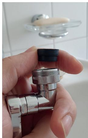
2. Lege nun **die dicke, grosse, schwarze Dichtung** oben in den Swivel. Wie im Bild mit der breiten Seite der Dichtung nach oben.
