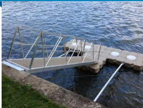
La technique des bras d'ancrage est une option moins utilisée mais peut s'avérer nécessaire dans certains cas. De façon générale, l'ancrage d'un quai flottant selon cette technique imposera quelques restrictions de base :
