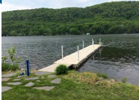
La méthode d'ancrage des pieux est l'une des approches les plus courantes et les plus populaires. Ils offrent une stabilité inégalée au quai flottant qu'ils soutiennent; ils sont souvent l'option préférée si l'environnement et les conditions le permettent. L'ancrage d'un quai flottant avec pieux nécessitera les conditions ci-dessous :
