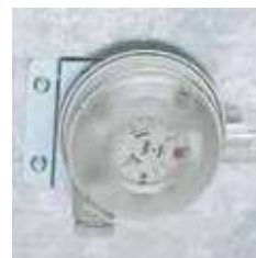
Pressostato colocado no interior da caixa.
