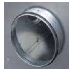
Juntas de estanqueidade nas bocas de aspiração.
