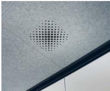
Die Frischluft wird über ein in der Akustikdecke integrierten und unsichtbaren Schalldämpfer in den Raum gezogen
