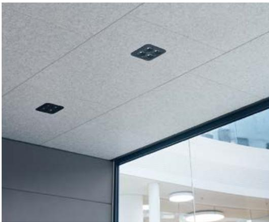
Die PET-Filzpaneele an der Decke und die komplett gedämmte Technikwand verbessern die Nachhallzeit des Raum-in-Raum-Systems.
