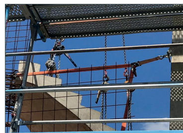
Positionierungsarbeiten bei dynamischen Lasten
