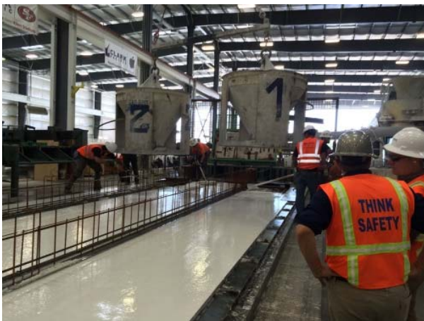
Figure 21– Soffit Pour – SCC White Concrete
