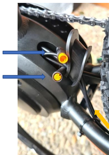
Fig. 4 Demontering av eksisterende hastighetssensor
