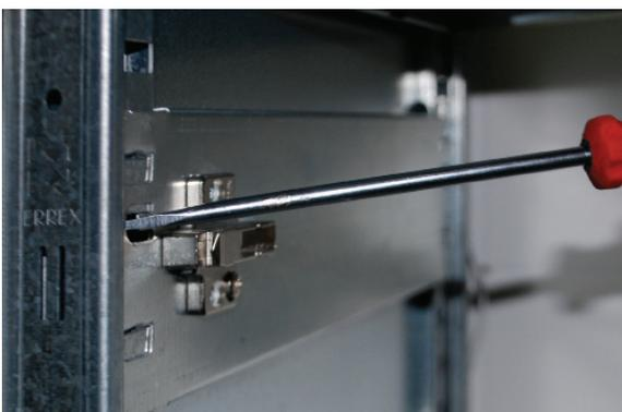
Mit dem Schraubenzieher die beiden Näschen jeder Stabilisationsplatte leicht in die Vertiefung drücken, damit die Platte sich nicht lösen kann.
