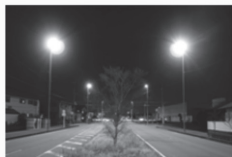
某市道(道路用LED照明)
