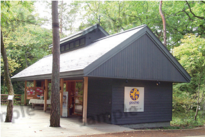
ピッキオ ビジターセンター（長野県）
