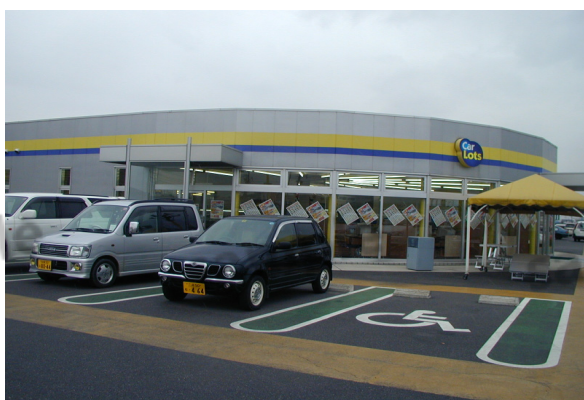
<店舗北側の外観・障害者パーキング>
