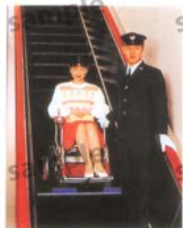
車いす用ステップ付きエスカレーター Escalator installed steps for wheelchairs
