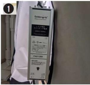
1.LED電源装置は必ず縦置き設置する必要があります。ケーブル側を下にして支柱に結束バンドで固定してください。
