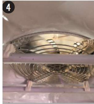
4.ファンの側面の周りは付属の紐を引っ張って隙間をなくすようにしてください。ファンの底部とテント上面の高さがあうようにしてください。
