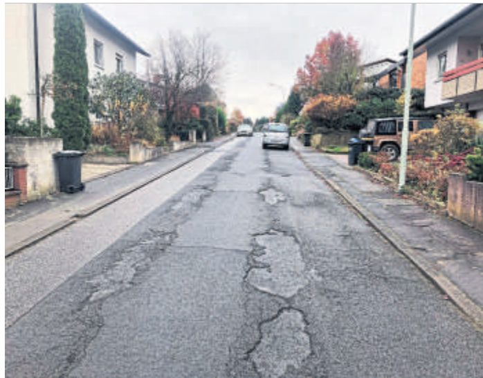
Für die Erneuerung der Theodor-Völker-Straße werden die Grundstückseigentümer nicht zahlen müssen. (Bild: LW)
