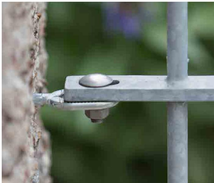
Enfin, vissez les vis à trou oblong. Lorsque vous aurez vissé les vis à trou oblong avec les écrous et les rondelles, la vis à trou oblong sera située fermement contre le poteau. L'écrou devra, pour cela, être vissé jusqu'au bout de la tête de la vis à trou oblong. Les œillets sont positionnés de manière horizontale.
