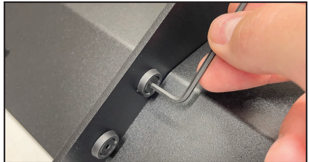
STEP 4 - INSTALLING FIN HARDWARE
